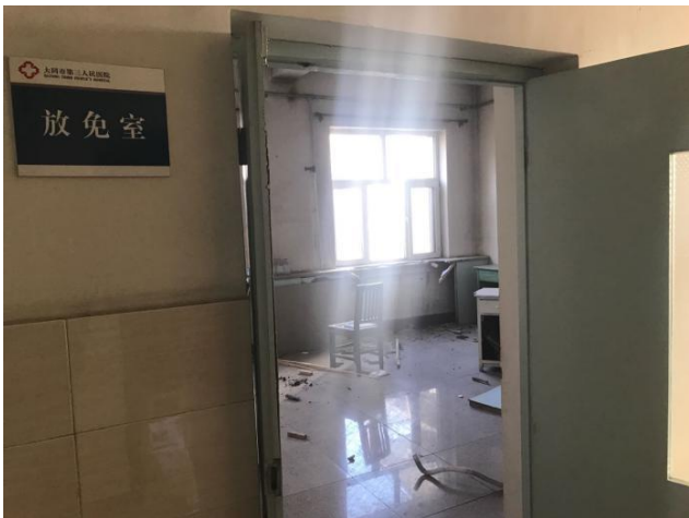
核医学科二层放免室
