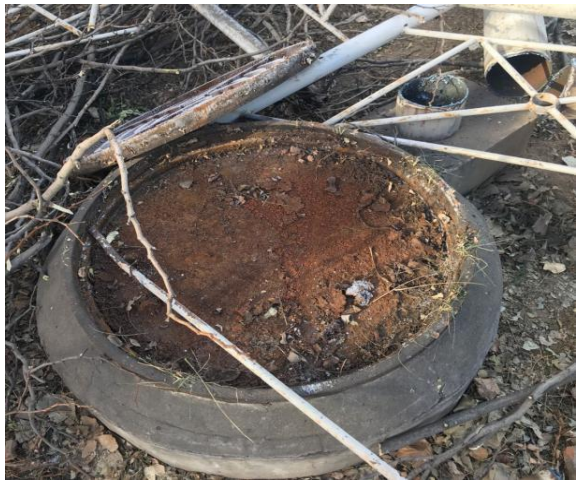
核医学科衰变池
