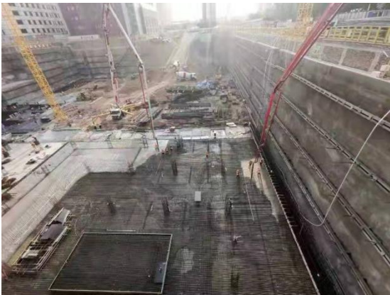
新建医技、急诊楼施工现场 3
