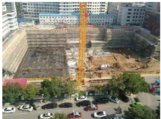
新建医技、急诊楼施工现场 6
