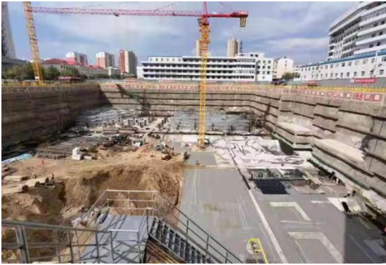
新建医技、急诊楼施工现场 1
