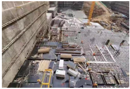
新建医技、急诊楼施工现场 2
