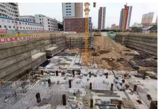
新建医技、急诊楼施工现场 5
