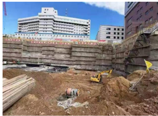
新建医技、急诊楼施工现场 4
