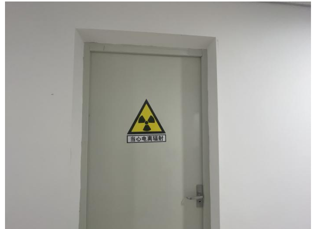
负二层给药室防护门
