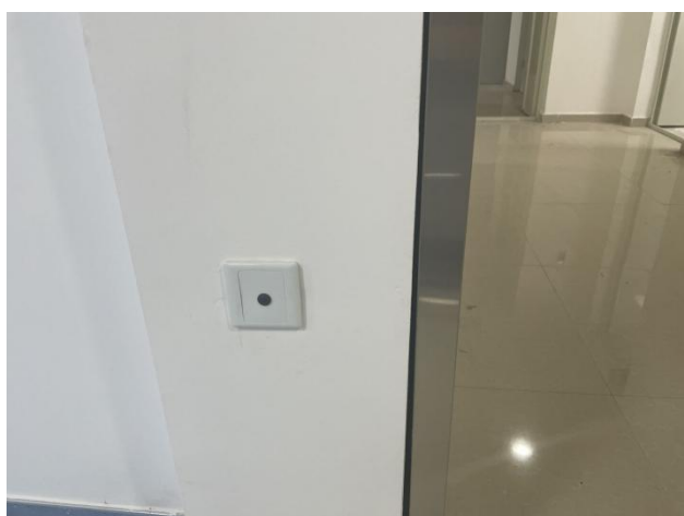
SPECT 室病人通道防护门防夹装置
